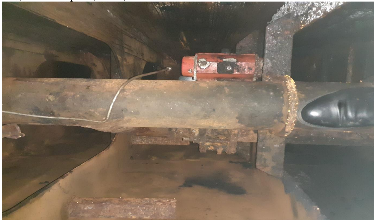
Фиг. 3 - Общ вид на шпилките на крана(поглед отгоре)
