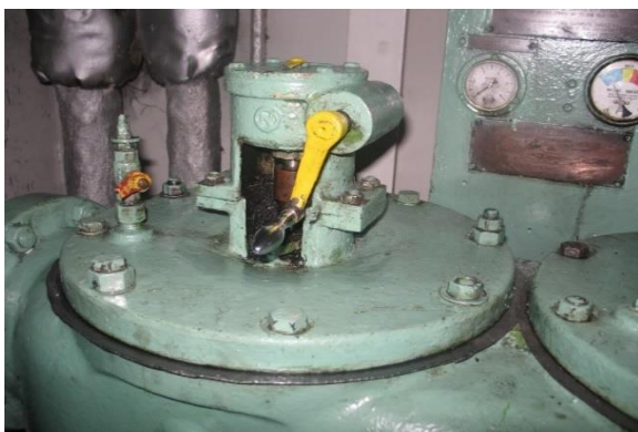
Фиг. 4. Капак на лявата секция на филтъра със системата за ръчно почистване.
