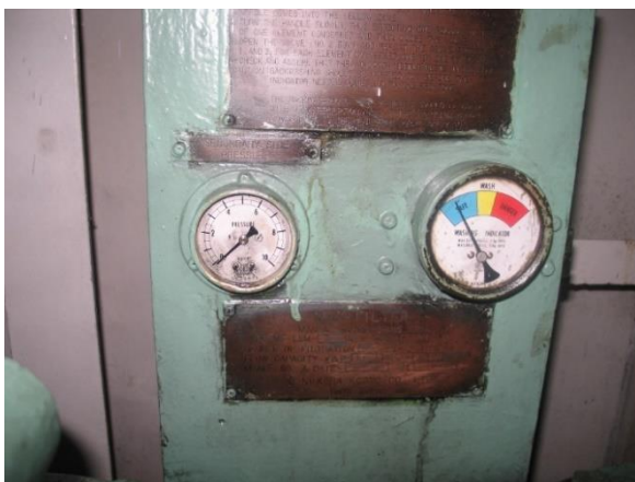
Фиг. 6. Манометри на МАХ филтъра
