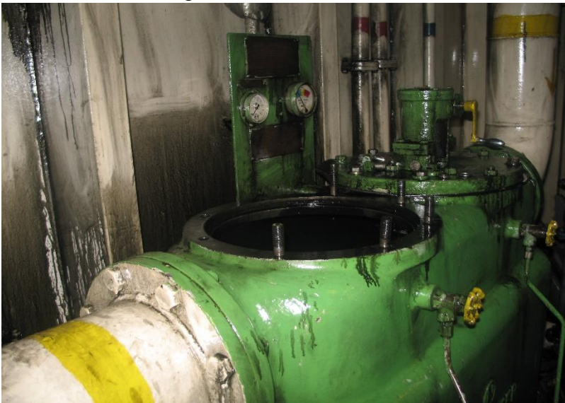
Фиг. 8. Гърловина на лявата секция с изкривени шпилки.
