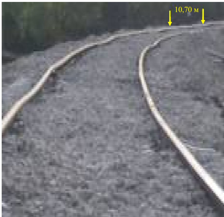
Фиг. 4.15. Състояние на железния път по ниво на мястото на дерайлиране, измерено на база 10,70 м на шестия вагон
